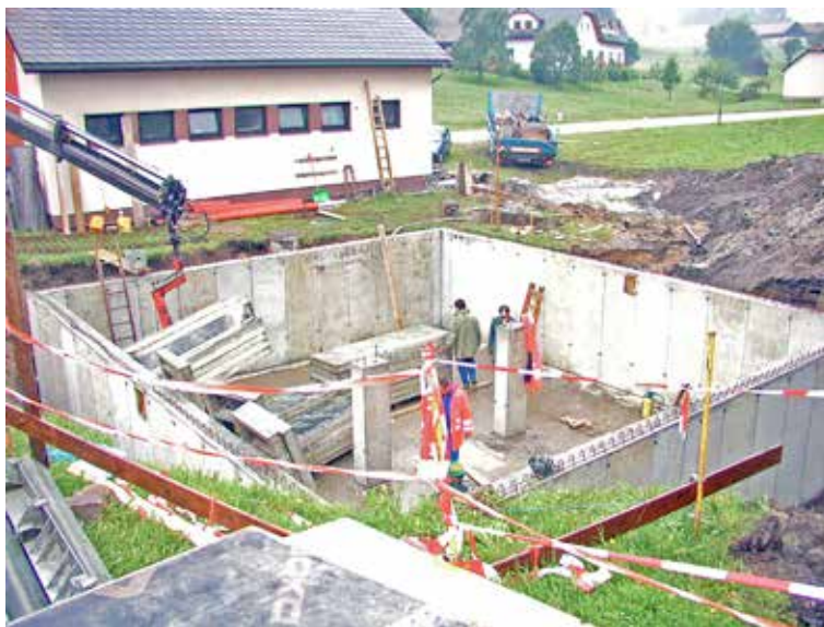
Von der Errichtung des Löschwasserbehälters ...
