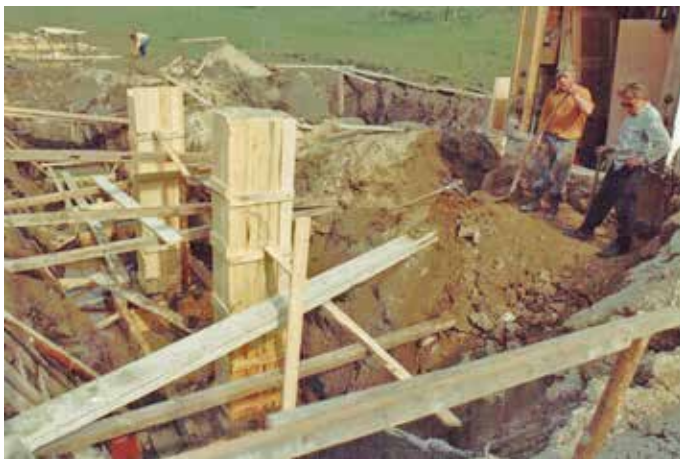
Errichtung des Fundaments für den Neubau in den 1980er Jahren.
